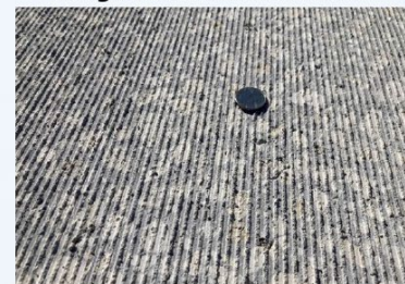
Longitudinal Diamond Grind
